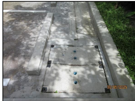
รูปที่ 1-6 ท่อระบายน้ำและร่องระบายน้ำ
