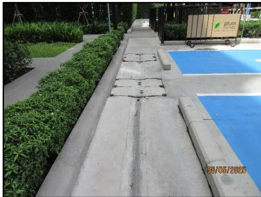
รูปที่ 1-6 ท่อระบายน้ำและร่องระบายน้ำ
