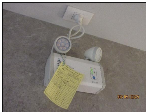
ระบบไฟฟ้าส่องสว่างฉุกเฉินของอาคาร B
